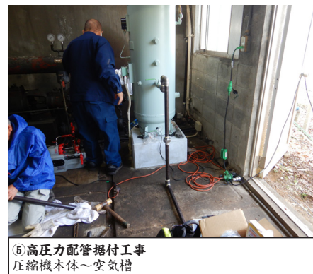
⑤高压力配管据付工事 圧縮機本体～空気槽
