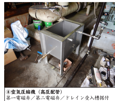
⑧空気圧縮機（高压配管） 第一電磁弁／第二電磁弁／ドレン受入槽据付
