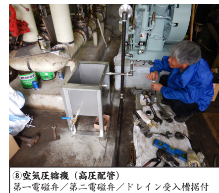
⑧空気圧縮機（高压配管） 第一電磁弁／第二電磁弁／ドレン受入槽据付
