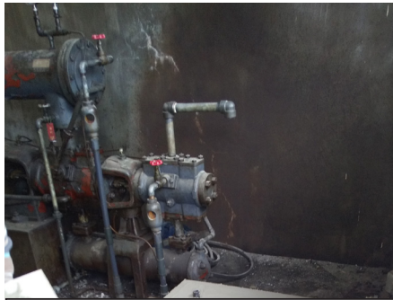
⑬補足 旧コンプレッサー取り外し施工
