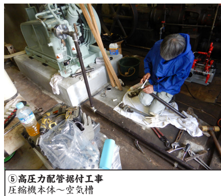
⑤高压力配管据付工事 圧縮機本体～空気槽
