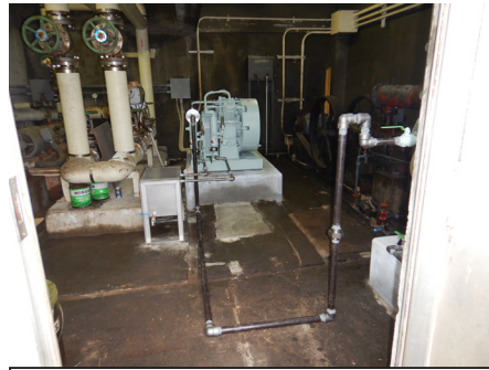
⑮試運転調整 完成
