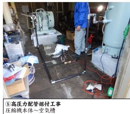
④空気槽＜新設＞（圧カタンク） 200ℓ×3.3Mpa
