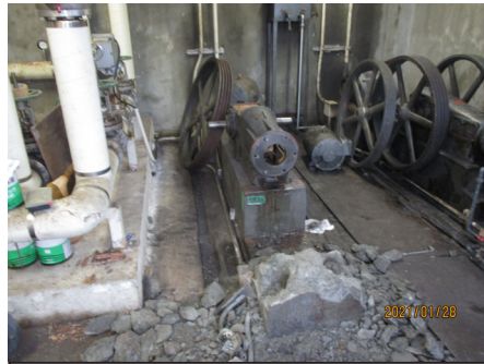
⑬補足 旧コンプレッサー取り外し施工
