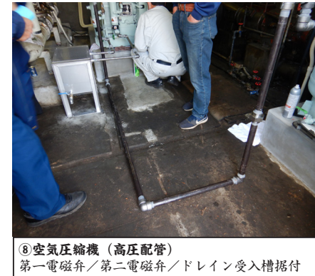
⑦高压力配管据付工事 空気槽ドレン管
