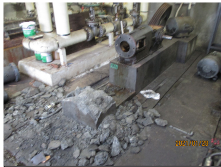
⑬補足 旧コンプレッサ取り外し施工
