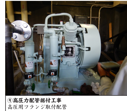
⑧空気圧縮機（高压配管） 第一電磁弁／第二電磁弁／ドレン受入槽据付
